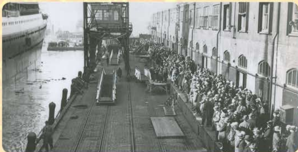
Op de vorige foto stond een watertoren op de hoek van de Verbindingsdam en de Oostelijke Handelskade, rond 1910
